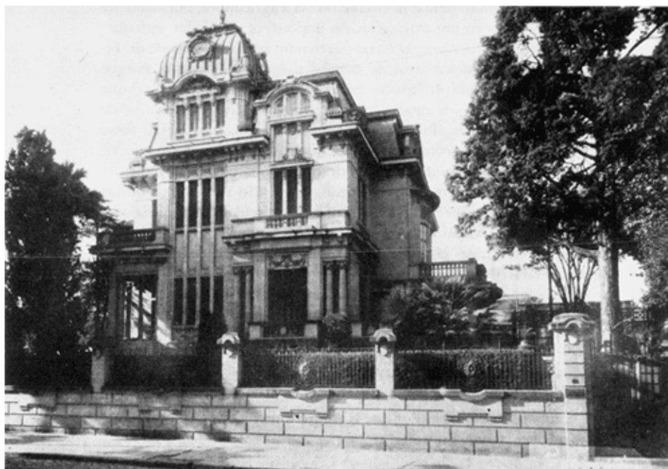
O primeiro prédio próprio da Faculdade de Filosofia, Ciências e Letras da USP
